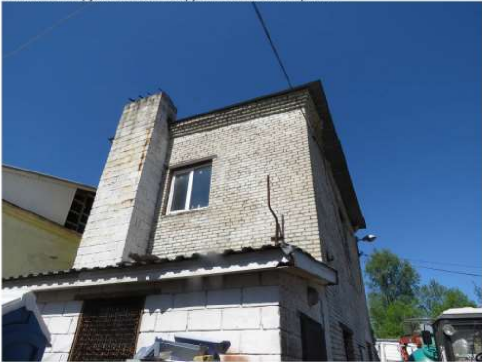
Фото 4. Общий вид двухэтажной пристройки.
