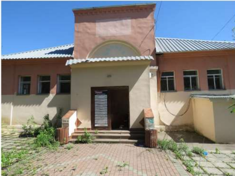
Фото 1. Общий вид одноэтажной части здания.
